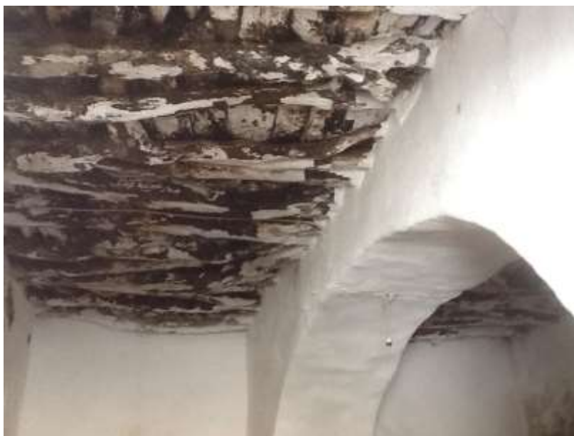
Εικόνα 12 Ενδιάμεσο βόρτο για μικρότερες αποστάσεις στήριξης του δώματος
