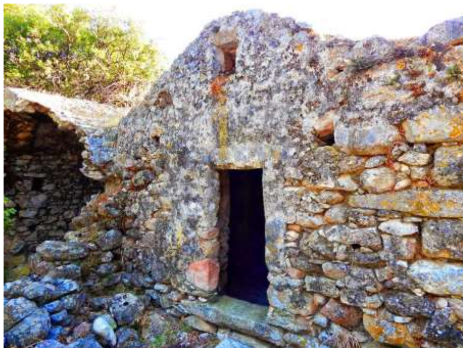
Εικόνα 6 Ανώφλι και κατώφλι του Βυζαντινού ναού του Αγίου Δημητρίου Χαλαντρών στον Κινίδαρο
