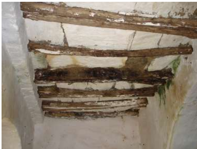
Εικόνα 13 Πέτρες τοποθετούνταν πάνω από τους κορμούς
