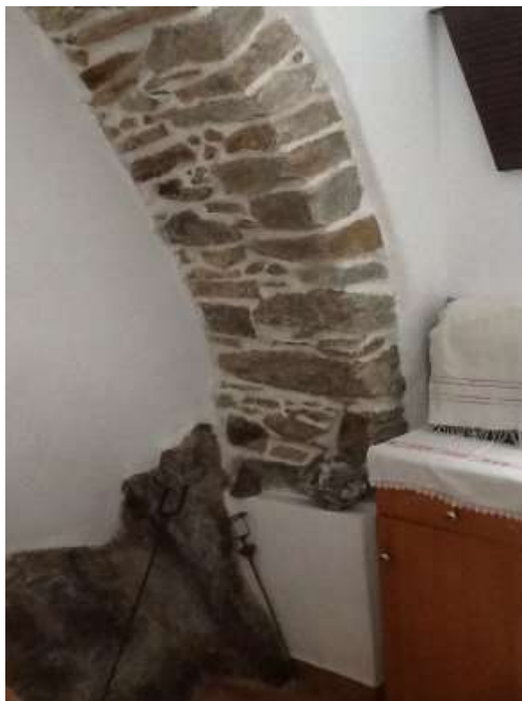
Εικόνα 2. Βράχος που εξέχει εξαιτίας της αδυναμίας να σπαστεί, σε αναπαλαιωμένο σπίτι
