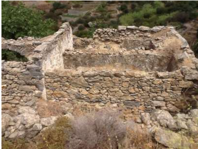
Εικόνα 3 Τοιχοποιία: φαίνεται ξεκάθαρα πως είναι τοποθετημένες οι πέτρες
